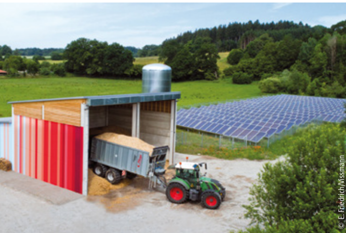
Holzheizwerk Moosach – vorbildliche Minderung mit Wärme aus regionalem Waldrestholz und großer Solarthermieanlage
